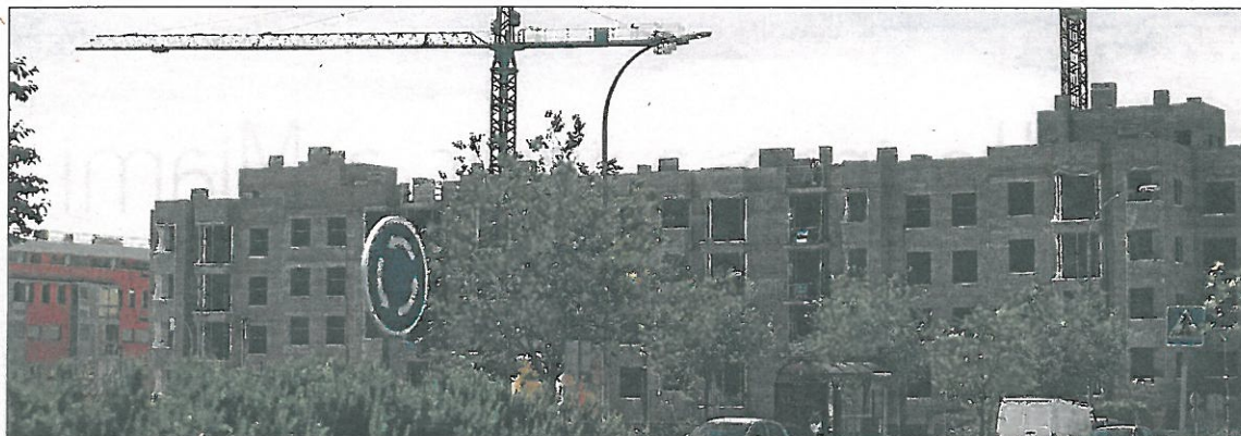
Imagen reciente de varios edificios en construcción en un nuevo desarrollo de Madrid. / SERGIO ENRÍQUEZ-NISTAL
