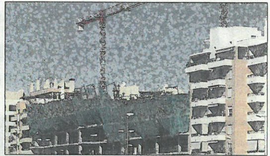
Edificio en construcción. EE
