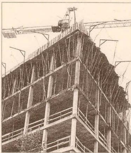
Una de las 700.000 viviendas que se iniciaron en 2005.
