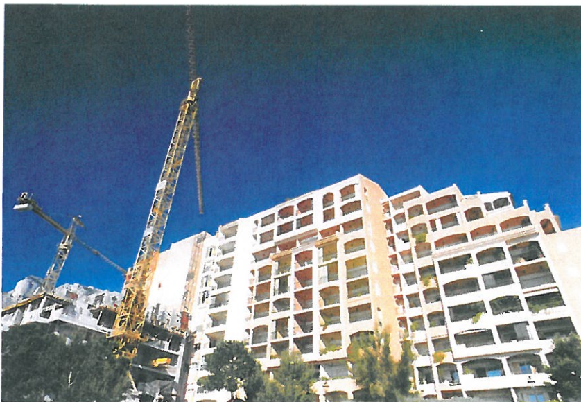
La capacidad de producción de la construcción es cinco veces mayor que su nivel de actividad real
