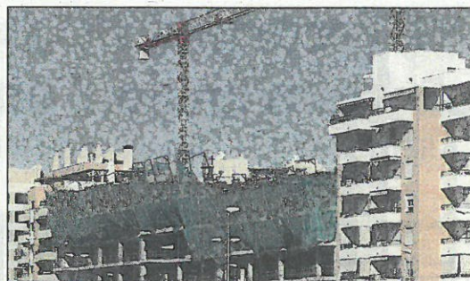
Edificio en construcción. EE
