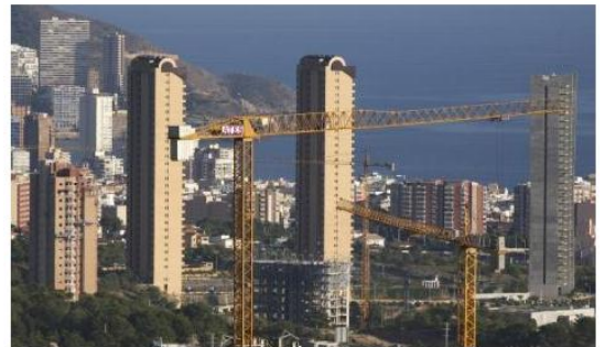
Obras de construcción de viviendas en Benidorm
