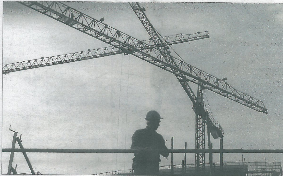
Un trabajador en las obras de construcción de un edificio de viviendas. / EL MUNDO
