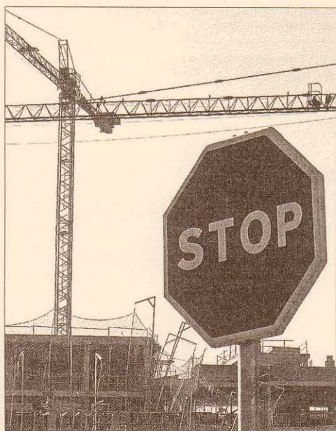
Una obra parada en Sevilla por la huelga andaluza de trabajadores.
